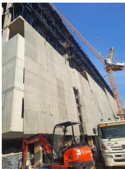
รูปที่ 9 พื้นที่ปิดสำหรับกิจกรรมก่อให้เกิดฝุ่นละออง
